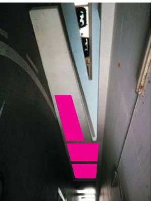
2. Wände an Aufahrt
